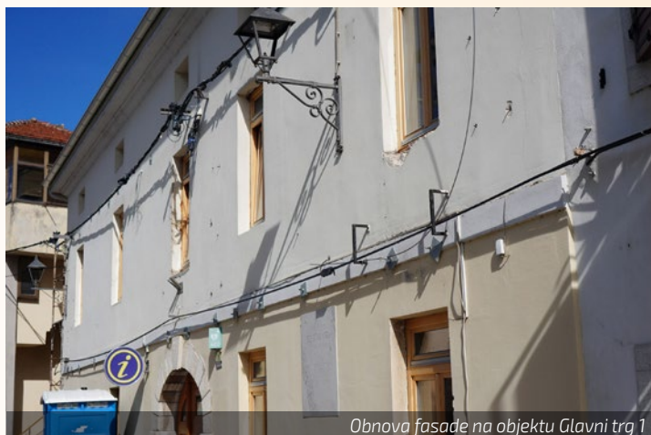
Obnova fasade na objektu Glavni trg 1
